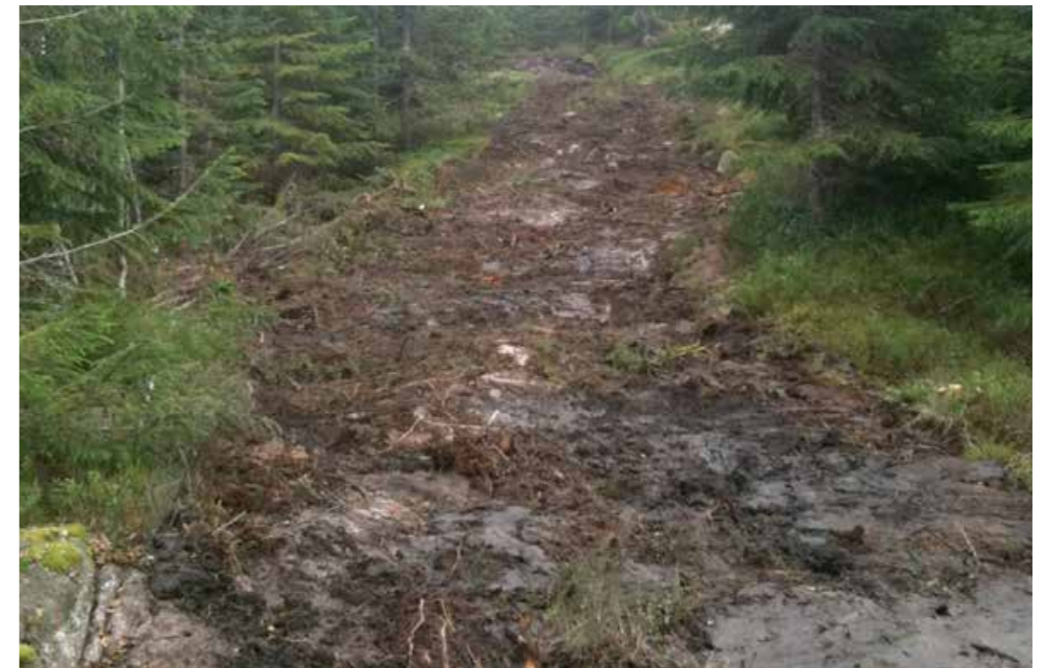
Planering av underlaget: Her har vegetasjon og steiner blitt fjernet for å skape trygge og fine forhold for skiløperne på vinteren.
