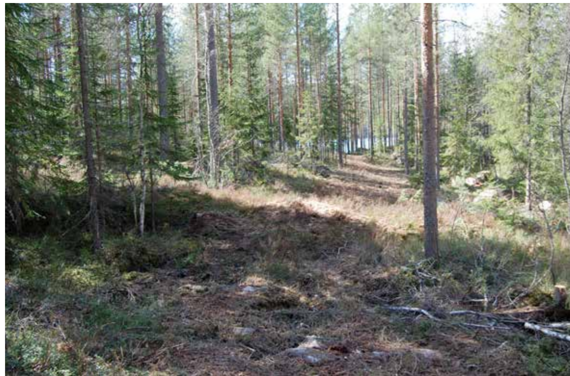
Planering av underlaget: I denne løypa trengs bare noe enklere planeringsarbeid.
