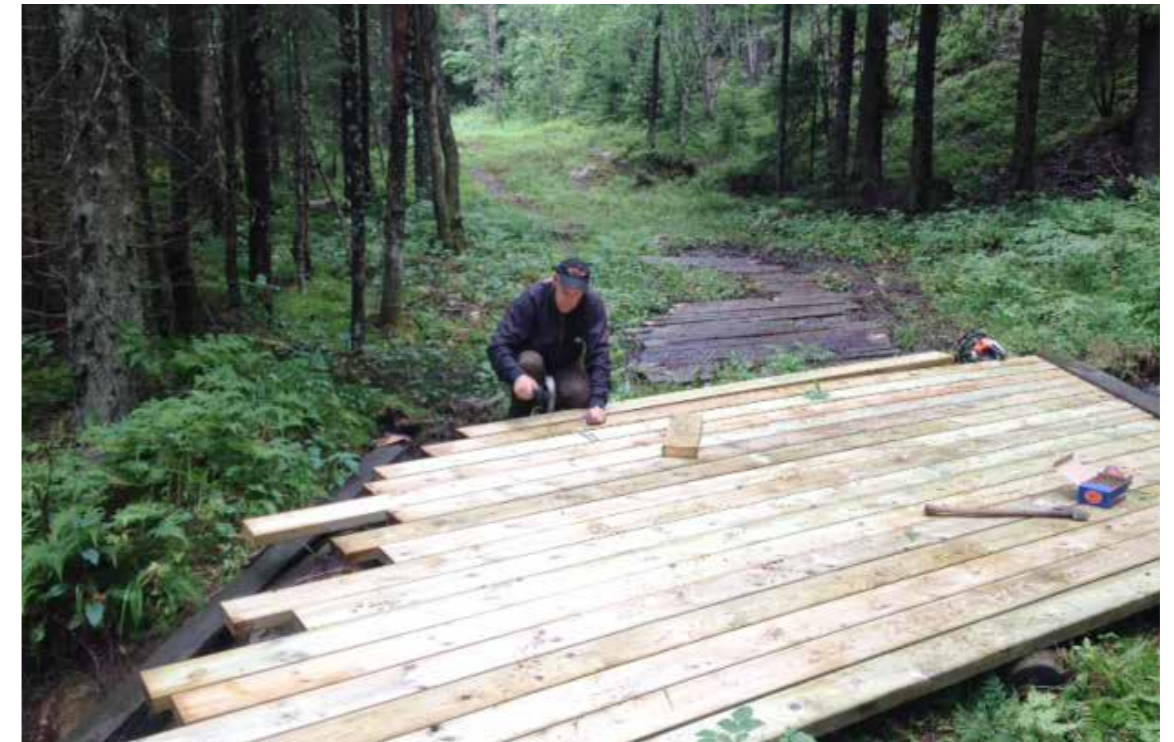
BRØBYGGING: For å kunne bære en løypemaskin kreves en solid brokonstruksjon.
