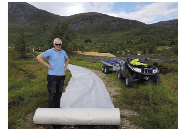
Duk og toppdekke ved Tønningsetra.
